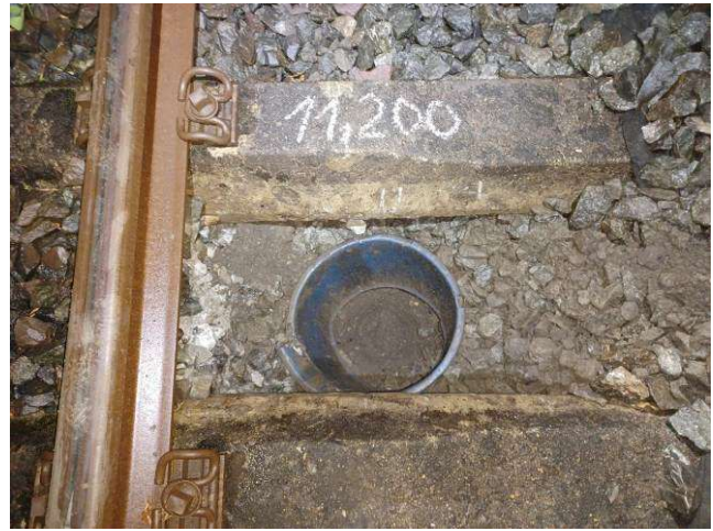
Bild 2: Abschnitt: Langeland – Ottbergen, km 11,200, Schurf im Schwellenfach
