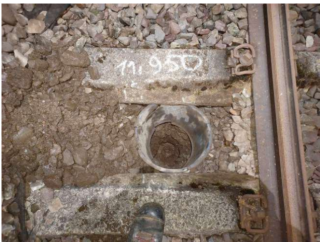
Bild 5: Abschnitt: Langeland – Ottbergen, km 11,950, Schurf im Schwellenfach
