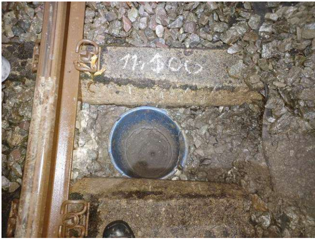
Bild 1: Abschnitt: Langeland – Ottbergen, km 11,100, Schurf im Schwellenfach
