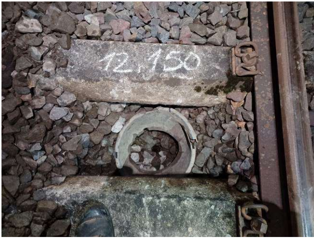
Bild 7: Abschnitt: Langeland – Ottbergen, km 12,150, Schurf im Schwellenfach
